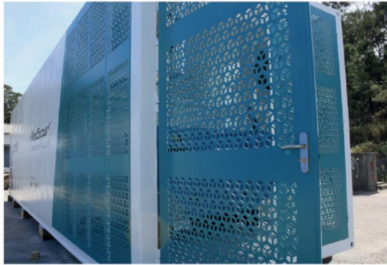
Ejemplo de perforación para circulación de aire
